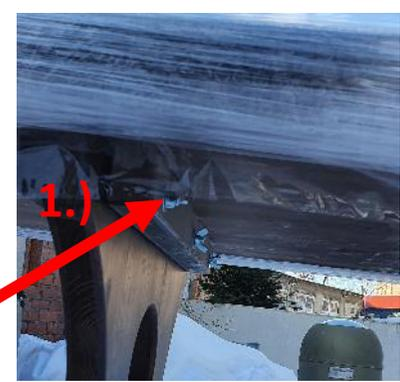
1. Tischbeine auserhalb der Hütte an Tischplatte montieren – pro Bein mit drei M10x170 Schrauben, Beilagscheiben und Muttern
